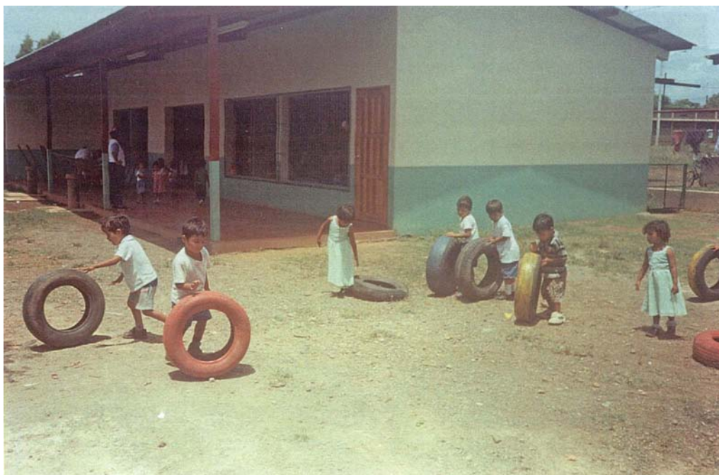
Aulas terminadas y servicios higiénicos
