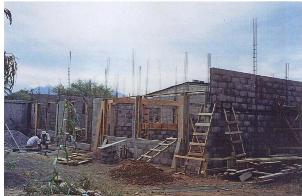
Construcción de dos aulas
